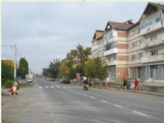
Reabilitare arteră principală - Buhuși
